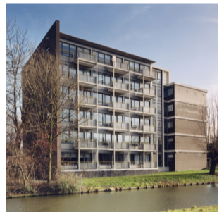
Renovatie Centrum Abstuoude Delft 1988-1991
