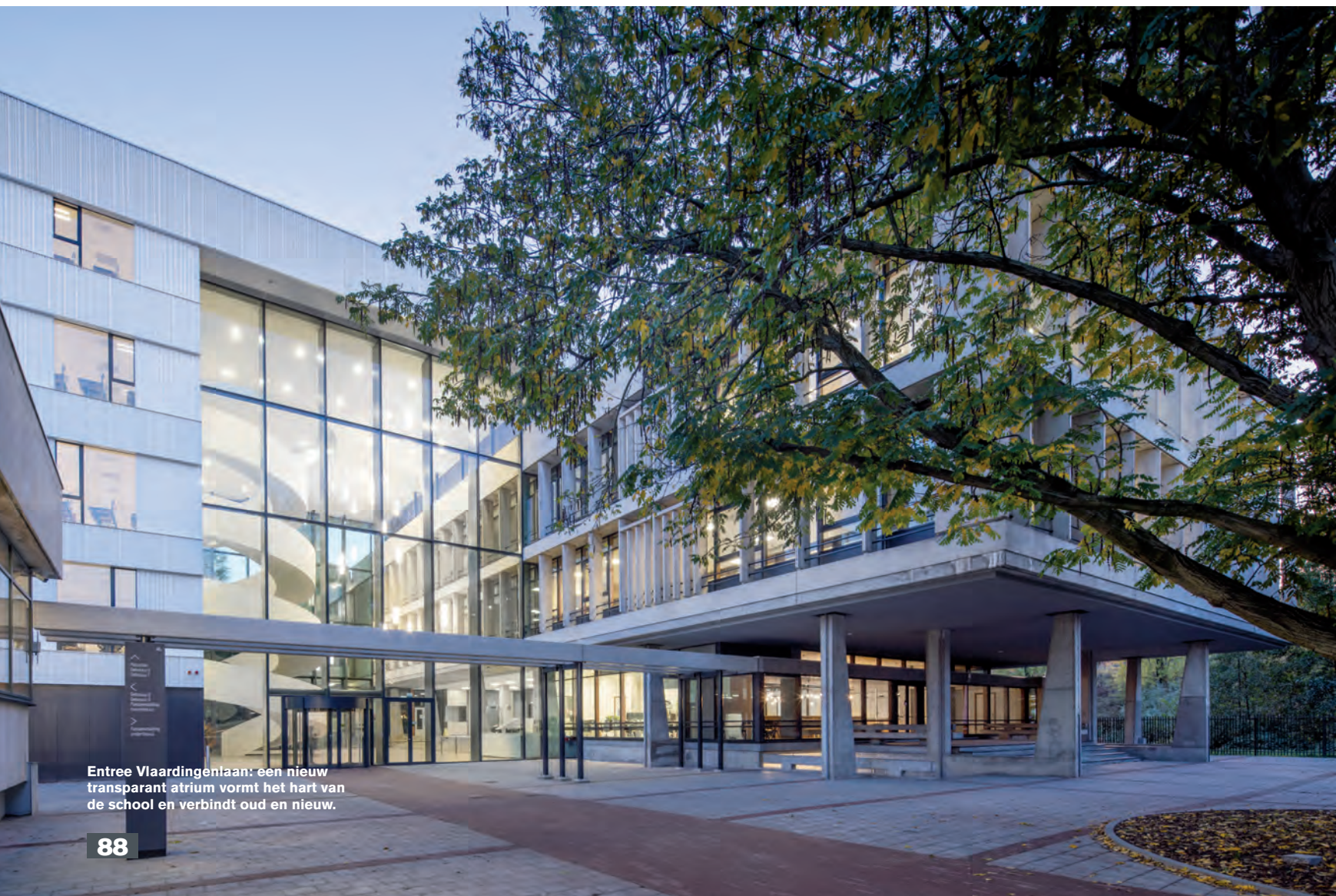
Zicht vanaf de Vlaardingenlaan: links de twee behouden praktijklokalen, daarachter de vijfde etage nieuwbouw en rechts de gerenoveerde oudbouw.
