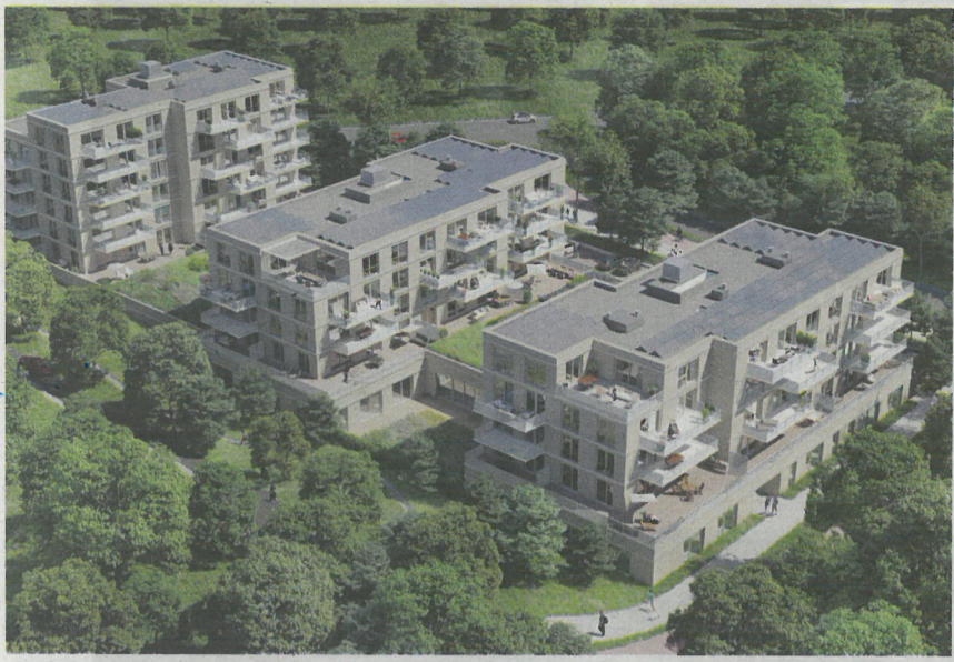
Atelier PRO heeft Zuiderduinen zoveel mogelijk in het landschap willen integreren. | Artist's impression: Beeldenfabriek
