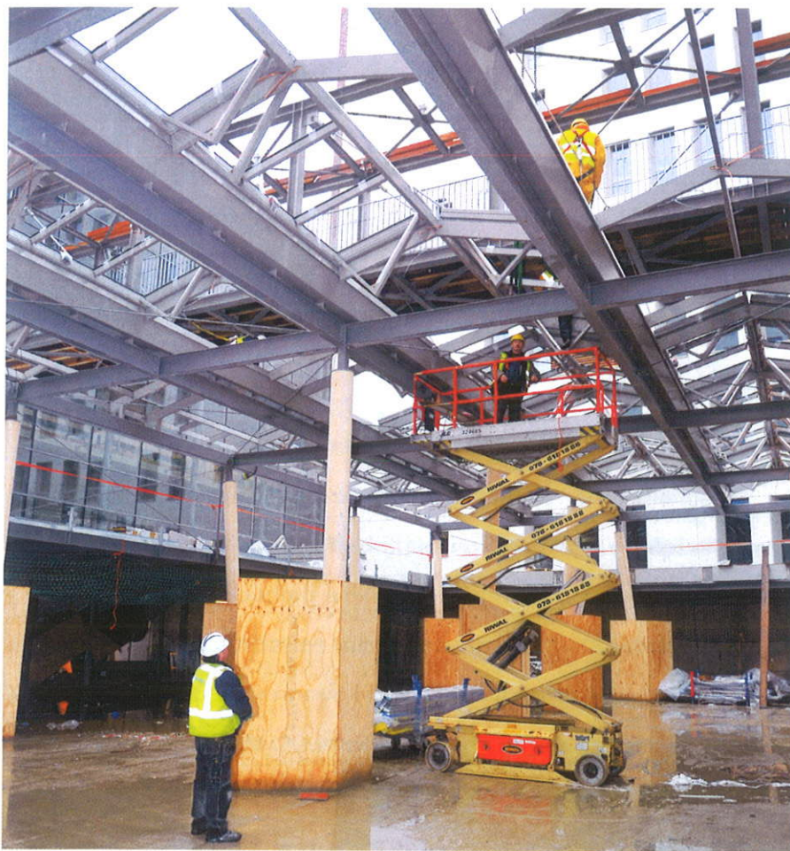
Inbouw van de RWA-luiken met zomerventilatiefunctie, een unicum.
