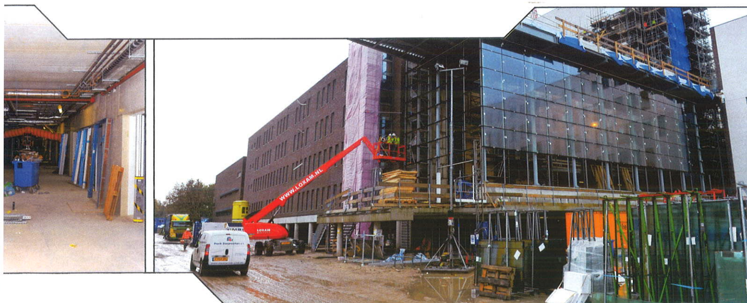
Het ziekenhuis is in de afbouwfase.
