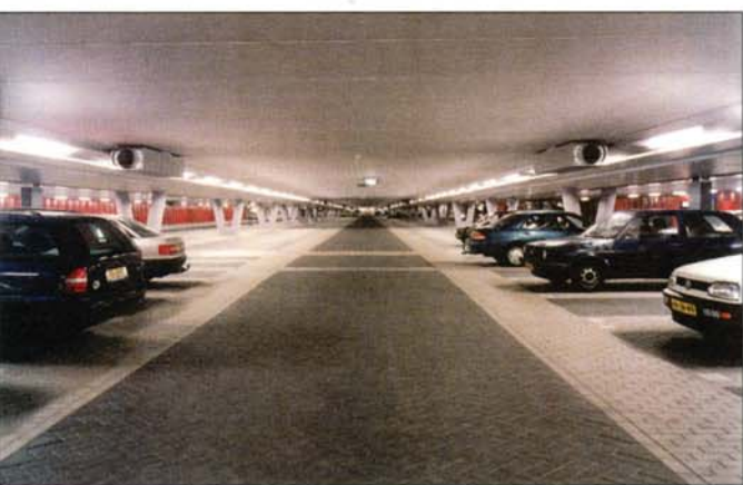
Parkeergarage Laakhaven, transparante ruimte door V-vormige kolommen.
