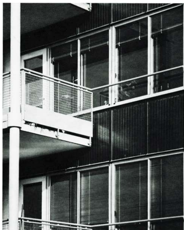
De gevelcollectoren lopen gedeeltelijk achter het daarvan vrijgehouden balkon langs. De speciale zonwering tussen de schuiframen is bijna overal standaard aangebracht in de op de zon gelegen gevels.
