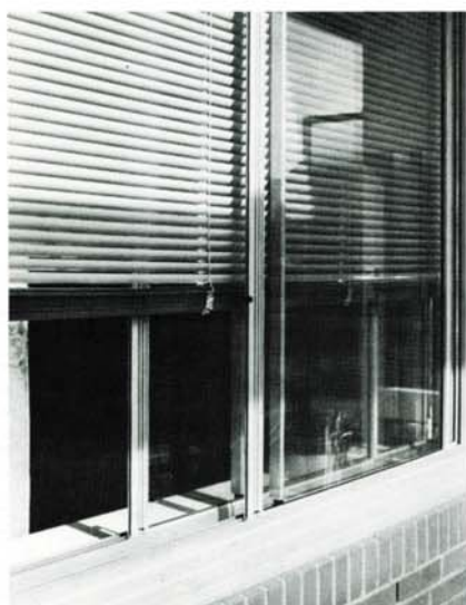
Zonwering tussen twee horizontaal schuivende ramen. Langs een der stijlen een ventilatierooster.
