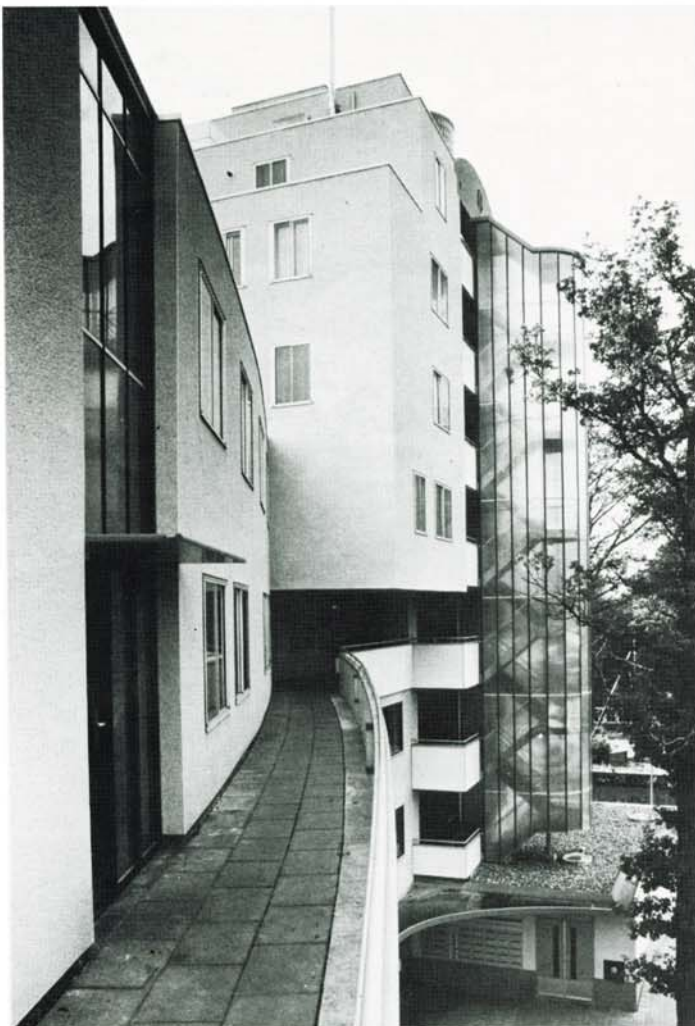
De noord-oostzijde wordt in schaal aangepast door een galerij op de derde verdieping. Deze verbindt de traphuizen met elkaar en eindigt in de woontoren.
