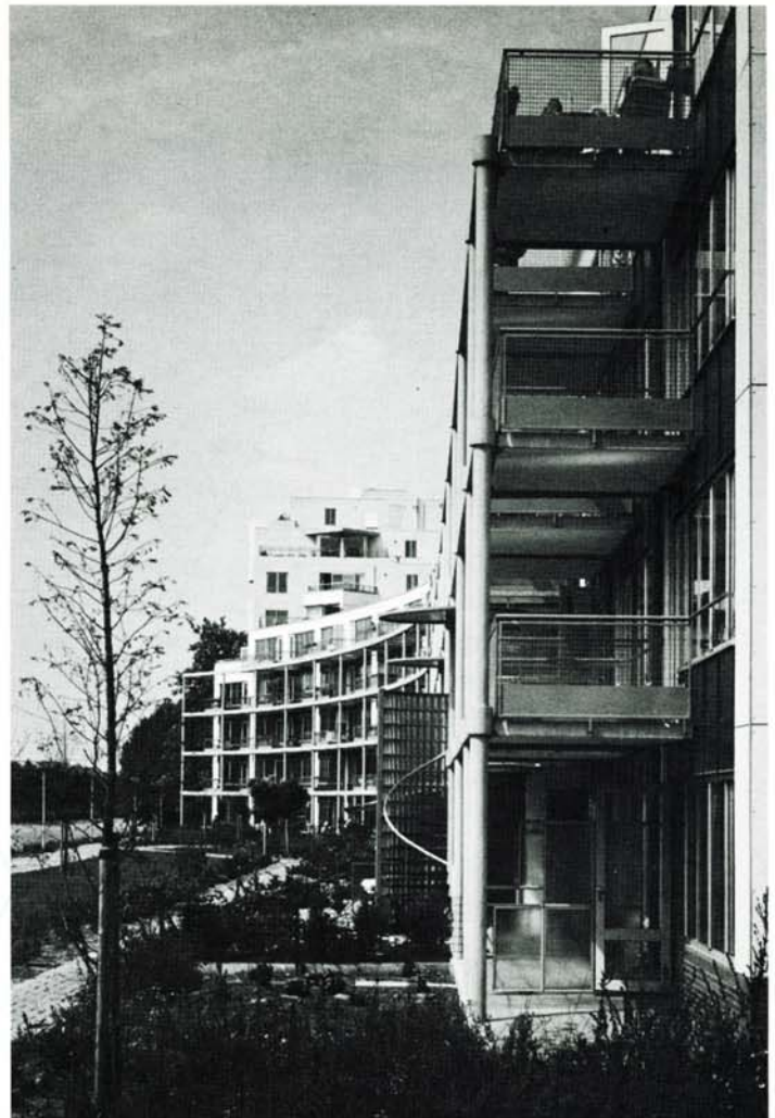
De bovenwoningen met een entree aan de Trekvlizijde hebben een ronde buitentrap.
