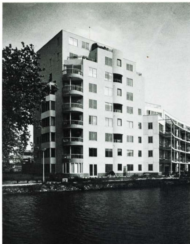
De woontoren heeft minder glas en geen gevelcollectoren als contrast met de laagbouw. Bovendien is hier een zandkleurige buitengevelisolatie toegepast in plaats van witte Fassalplaten.
