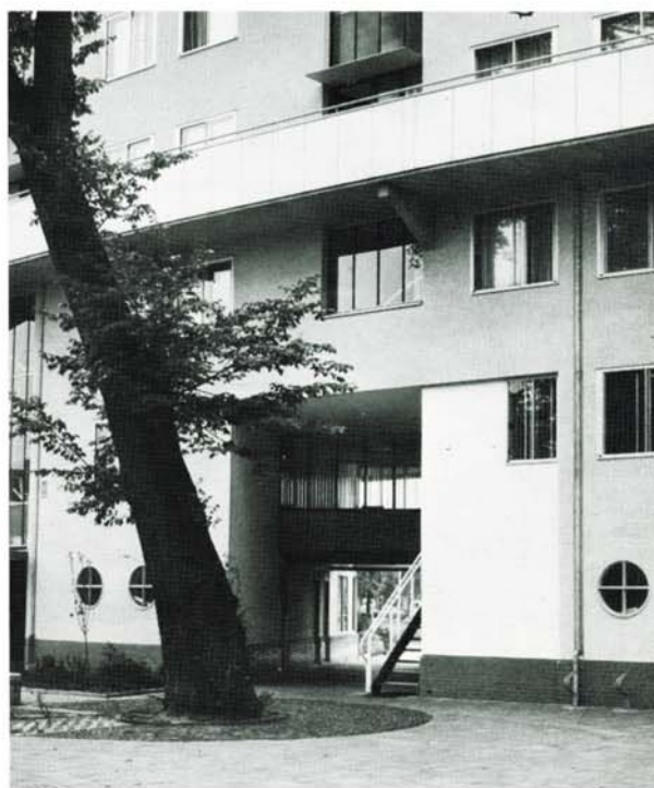
Onderdoorgang met ingehangen vergaderzaal, gezien vanaf het noord-oosten. Mede om graffiti gemakkelijker te kunnen overschilderen is hier vlak wit pleisterwerk toegepast in plaats van zandkleurig structuurpleister.
