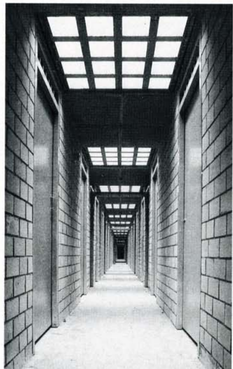
11. Gang tussen bergingen onder de straat; wat opvalt is de lichttoetreding via glazen bouwstenen op straatniveau
